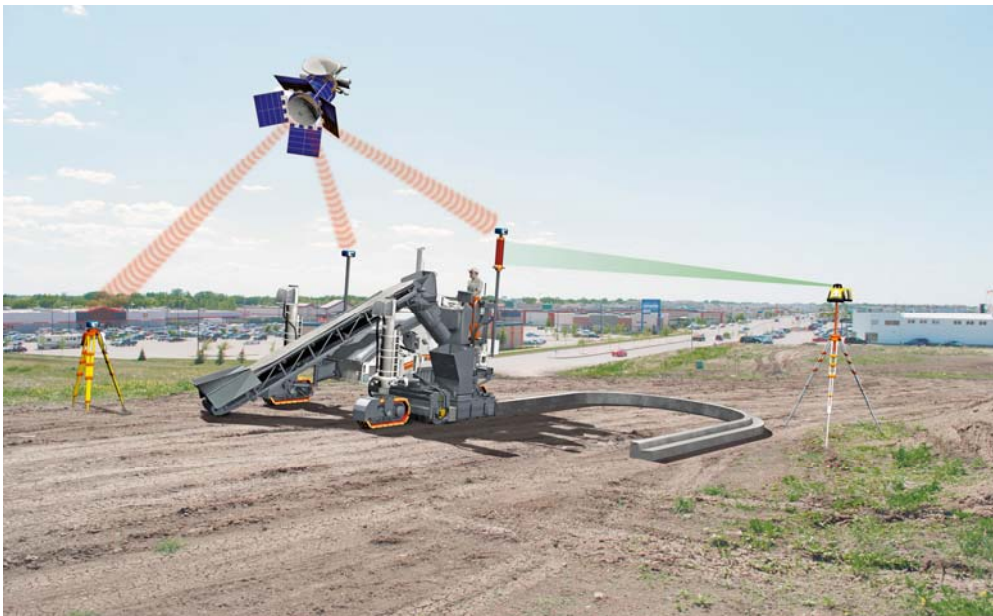
Postavitev na gradbišču pri uporabi Wirtgenovega sistema za 3D krmiljenje: tako je zagotovljena visoka stopnja natančnosti
